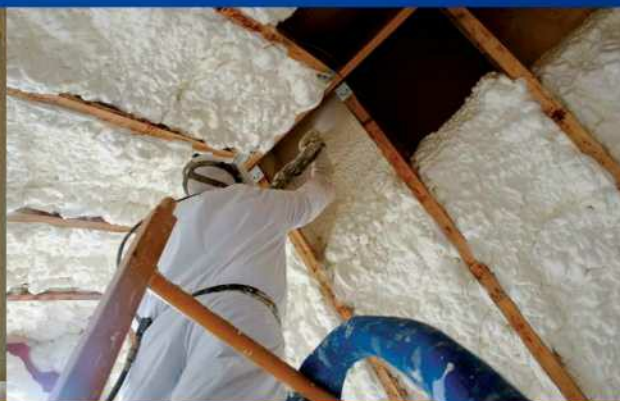
IZOLIRANJE PODSTREŠIJ
